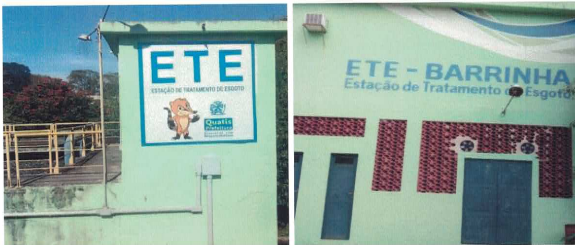
Figuras 37 e 38 – Estação de Tratamento de Esgoto ETE Barrinha
