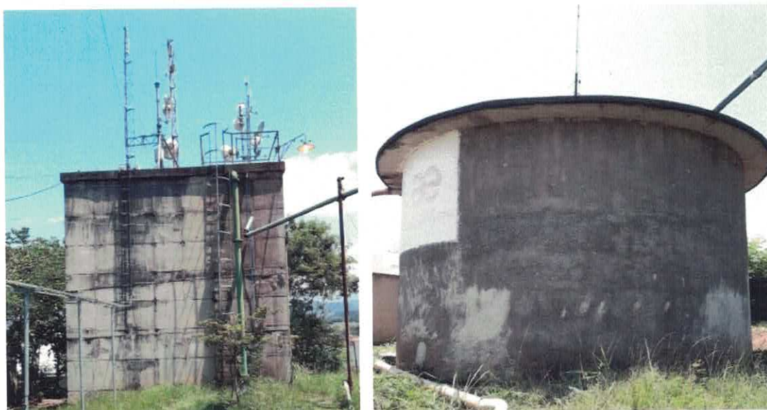
Figuras 28 e 29 – Reservatórios próximo da ETA Bondarovsky
