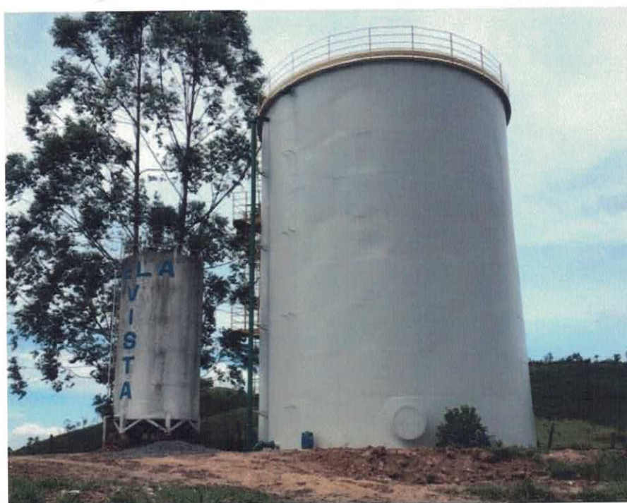
Figura 31 – Reservatório no Loteamento Bela Vista
